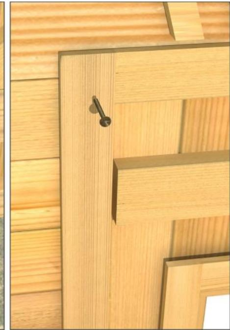
Asigurați-vă de o bună păsuire a ușilor înainte de a le fixa definitiv. Fixați apoi tocurile laterale în partea de jos cu două holzsuruburi în lambriul inferior, cu unul în primul lambriu întreg și în partea de sus cu un holzsurub în tocul superior. Folosiți holzsuruburi de 4x50.
